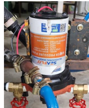
รูปภาพที่ 3.7 ปั้มน้ำขนาด 1/2 นิ้ว แรงดันไฟฟ้า 12 Volt สำหรับไหลเวียนน้ำในระบบ
